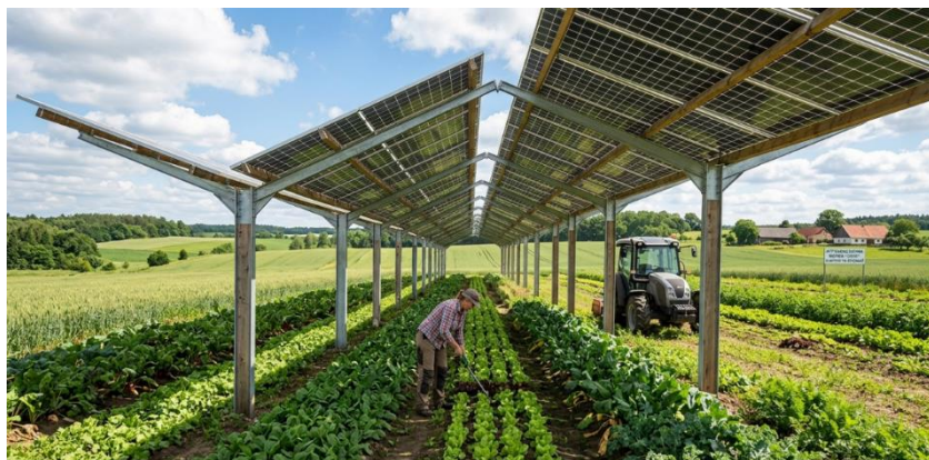
Рис. 1. Схема агровольтаїчної системи подвійного використання земель: генерація фотоелектричної енергії та вирощування сільськогосподарських культур
